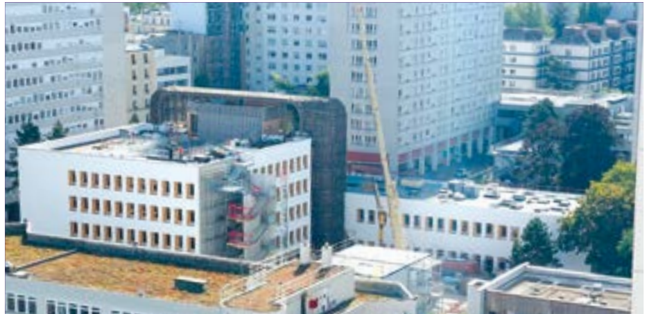
Place des Fêtes, une résille en bois verticale relie les bâtiments de la médiathèque (à g.) et de la Maison des réfugiés (à d.). À leur pied, sont attendus 4 000 mètres carrés d'espaces verts.
